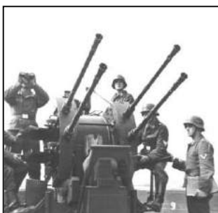
afweergeschut Flakvierling 38 met 20mm-kaliber
