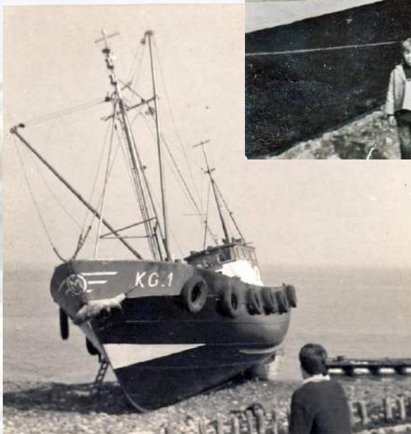
de KG 1 op de slikken te Colijnsplaat tijdens laag water voor het teren van de onderkant voor onderhoud
