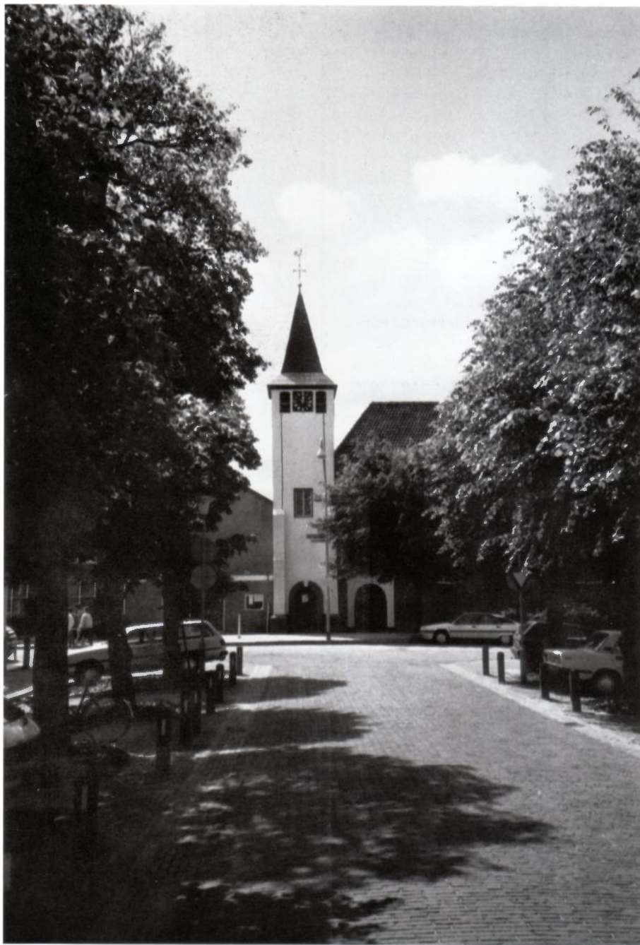
De rond 1607 gebouwde kerktoeren, die de zuidkant van de Voorstraat afsluit. (foto: H.H. Vogel).
